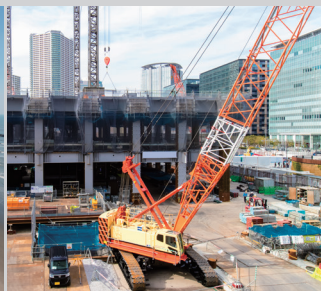
建築・工事現場
